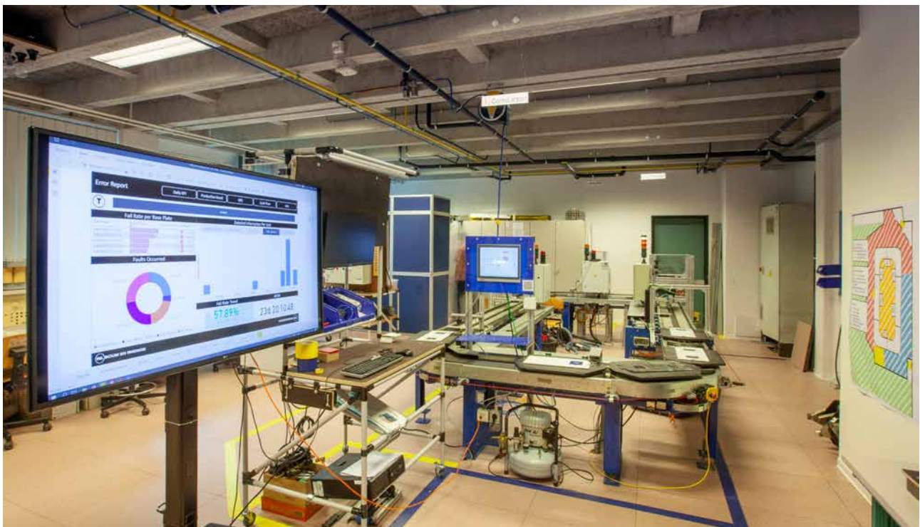
Een productielijn met een Beckhoff PLC verzamelt bijkomende data zoals spanning, stroom, temperaturen en trillingen.
